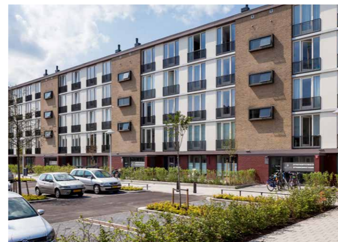
Referentie (plintwoningen Kanaleneiland, Utrecht)
